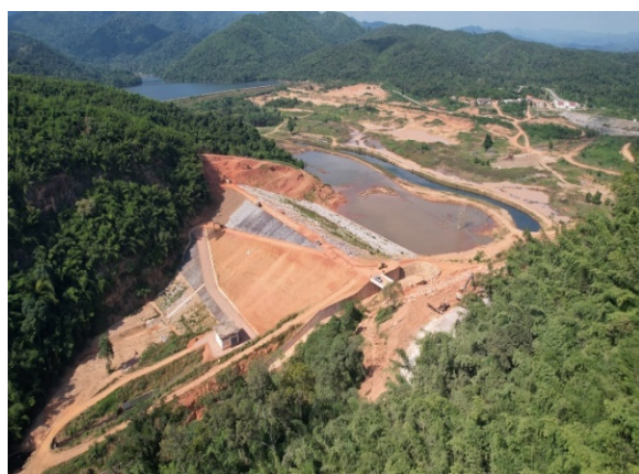
ภาพที่ 1.6-2 ทำนบดินเขื่อนหลัก
