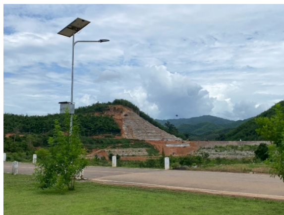
ภาพที่ 1.6-4 การเสริมความมั่นคงและป้องกันการกัดเซาะลาดไหล่เขาอาคารระบายน้ำล้น
