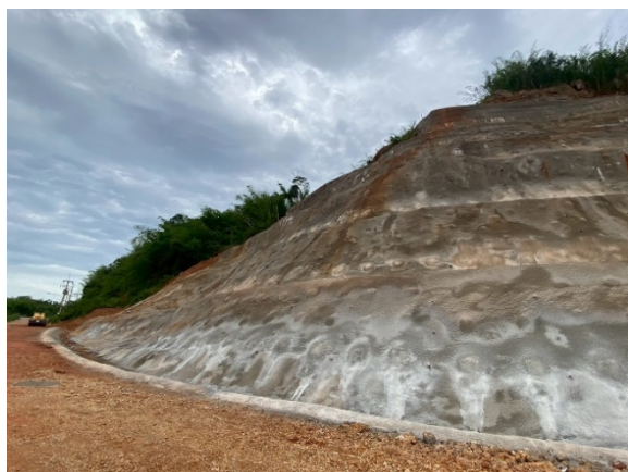
ภาพที่ 1.6-4 การเสริมความมั่นคงและป้องกันการกัดเซาะลาดไหล่เขาอาคารระบายน้ำล้น
